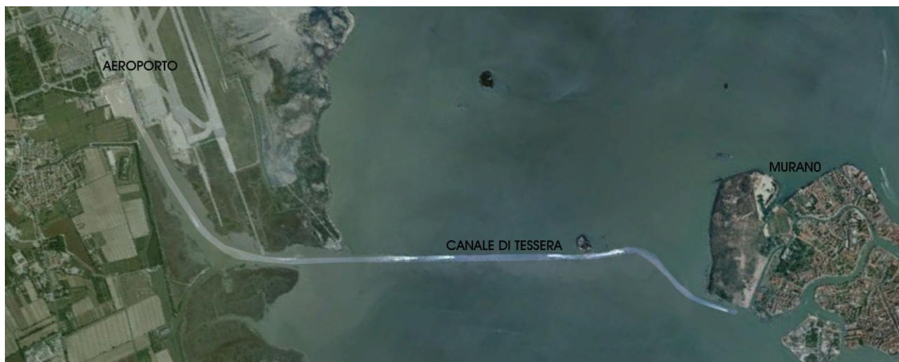
Foto 2- nel dettaglio il canale di tessera per cui si propone l'illuminazione fotovoltaica
