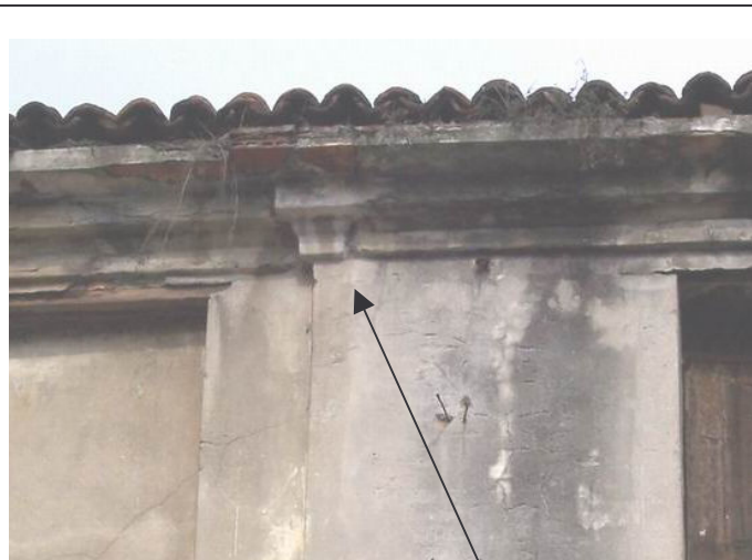
Elemento del cornicione in Pietra d'Istria (parte sinistra)
