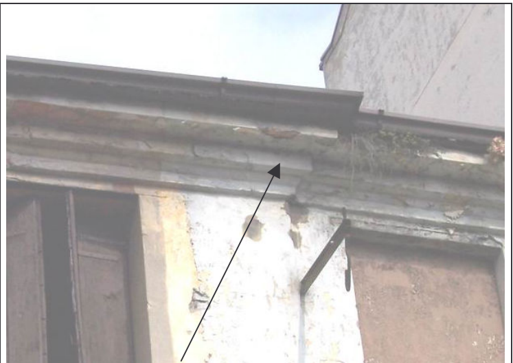
Ipotetico elemento del cornicione in Pietra d'Istria sotto la dipintura (parte destra)
